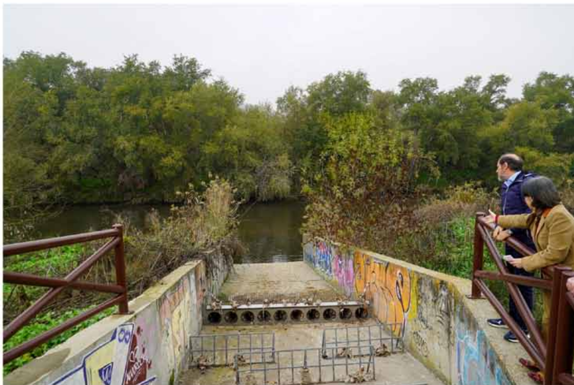
El Canal despliega una campaña sobre el peligro para el medio ambiente de arrojar toallitas al inodoro
