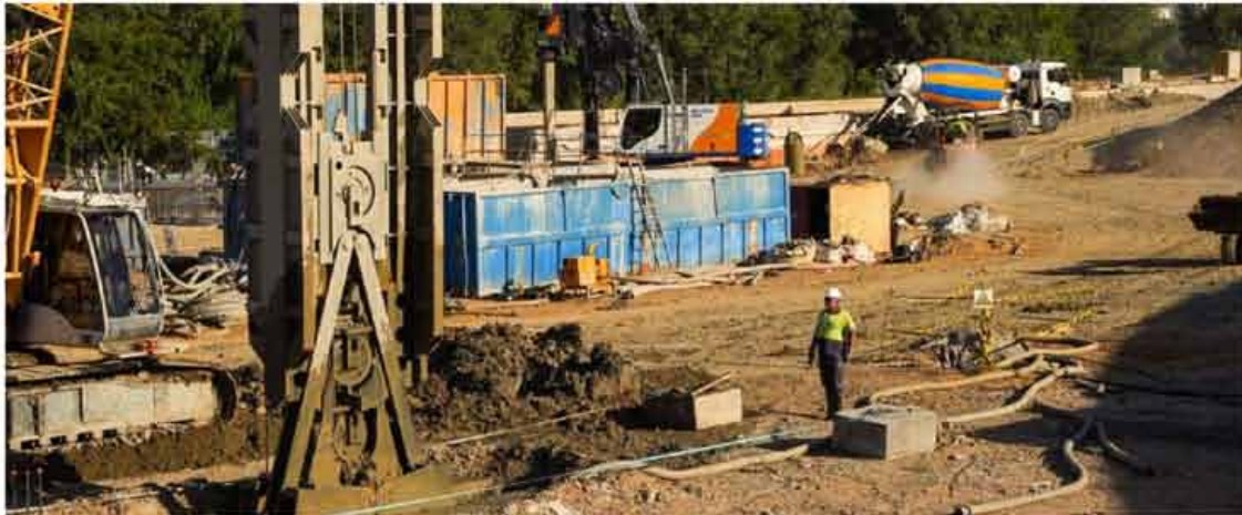
Obras de construcción del tanque de tormentasLa Voz
