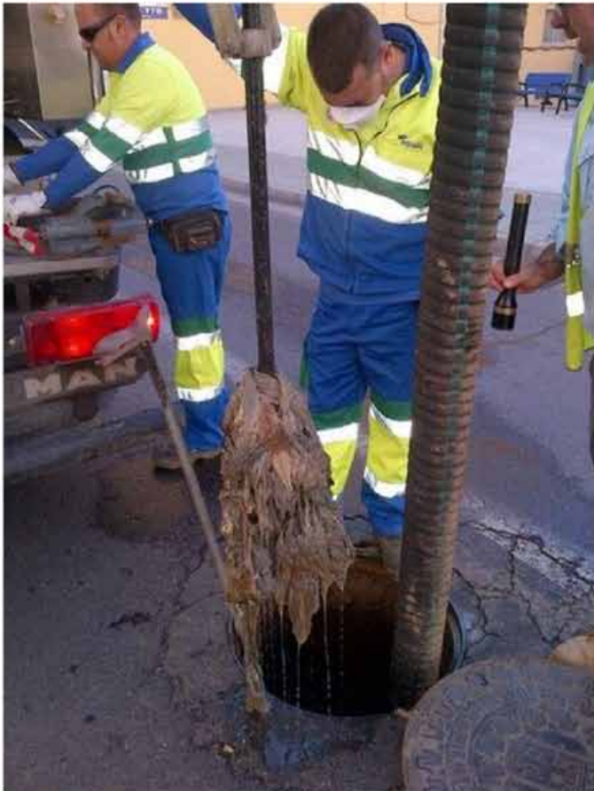
Limpieza imbornales Aqualia camión saneamiento
