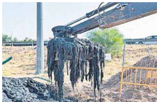
Retirada de una masa de toallitas que atascaba un colector.
