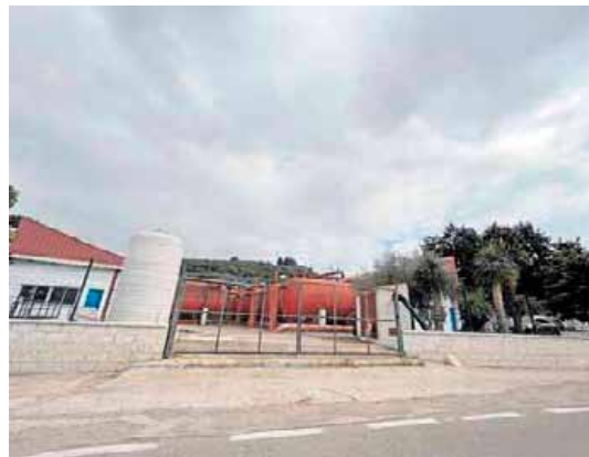
Imagen de la planta potabilizadora de El Trapiche en Vélez-Málaga. E. C.
