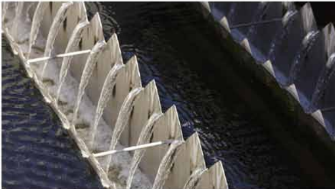
Tratamiento avanzado para la regeneración de las aguas residuales.
