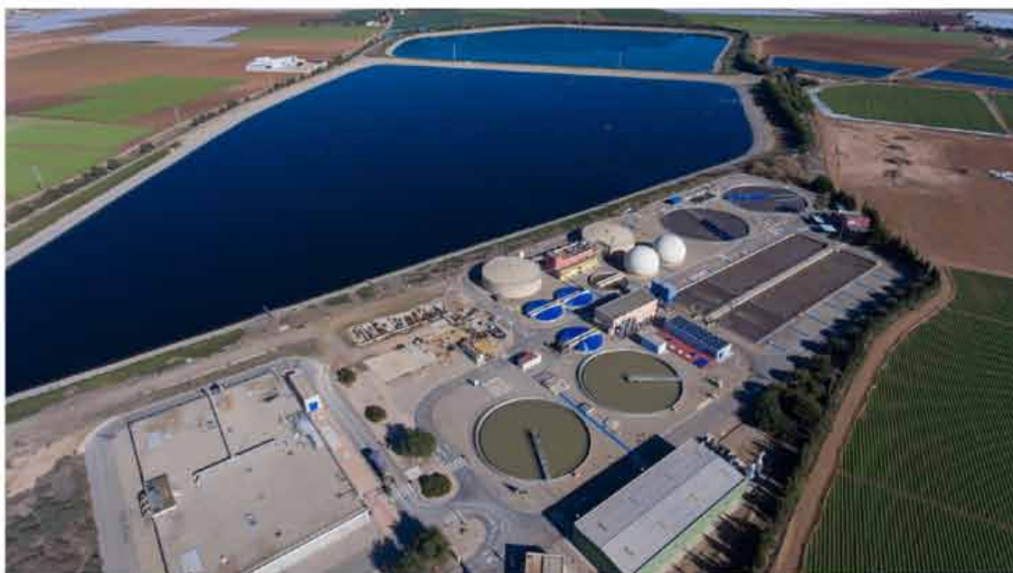
Depuradora Cabezo Beaza, en Murcia, otra de las instalaciones de Agbar.
